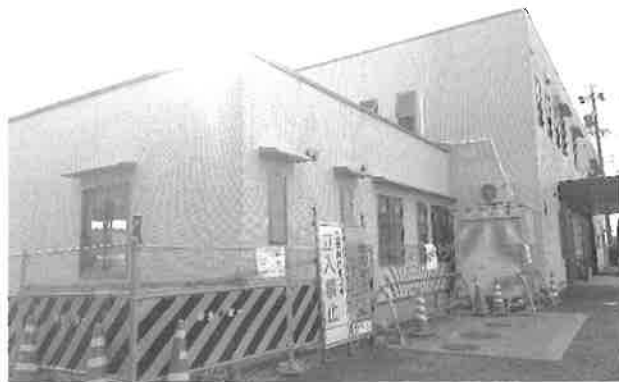
建物増築部分
